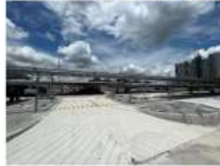
โครงการติดตั้งระบบบริหารจัดการลานจอดรถอัจฉริยะ สถานีคลองบ้านม้า และสถานี รพม. (สายสีส้ม)
