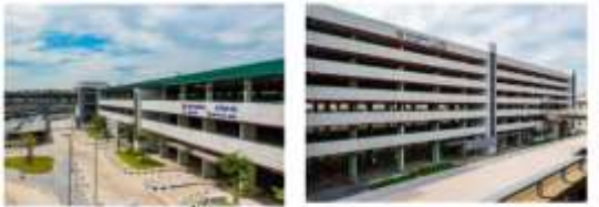
โครงการติดตั้งระบบบริหารจัดการลานจอดรถอัจฉริยะ ณ อาคารจอดรถสถานีแยก คปอ. และสถานีตุ๊กต (สายสีเขียวเหนือ)
