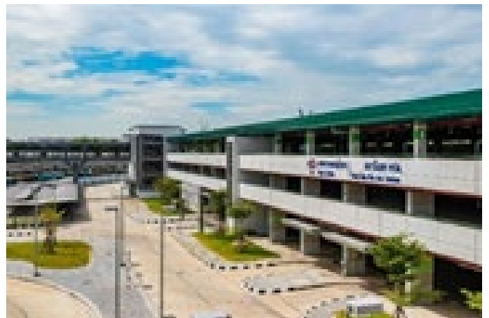
Exhibit 13: อาคารจอดรถแล้วจร 3 ชั้น สถานีแยก คปอ.
